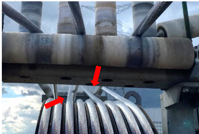
Rys. 11. Ustawienie bębna powodujące tarcie pomiędzy przewodami
