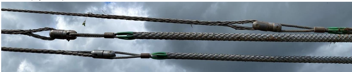
Rys. 15. Widok elementów do kompensacji skrętu przewodu
