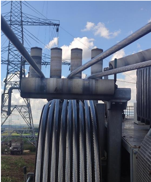
Rys. 10a. Widok niesymetrycznego rozstawienia bębnow
