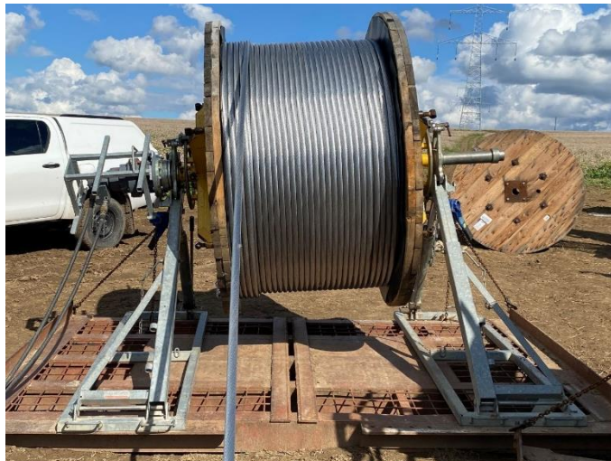
Rys. 8. Nieprawidłowe ustawienie bębna na stojaku
