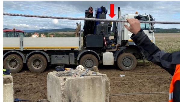
Rys. 14b. Widok sposobu kontroli optymalnej wartości naciągu – z obciążeniem
